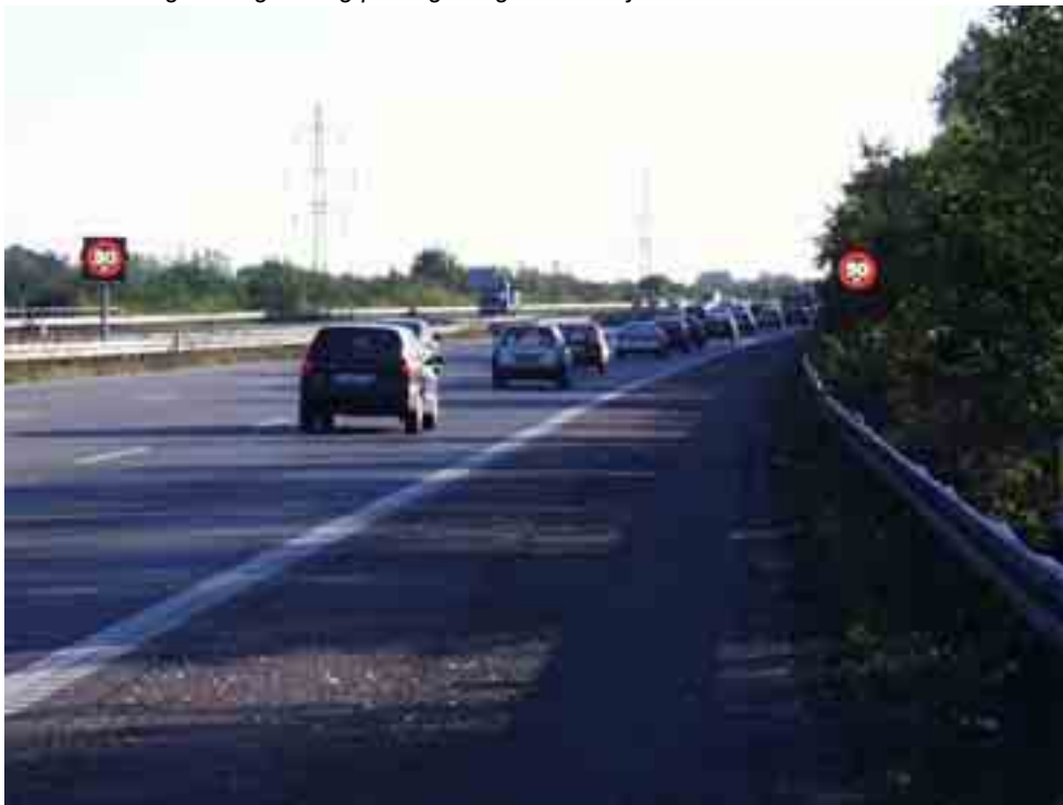
Variable hastighedsregulering på Køge Bugt Motorvejen
