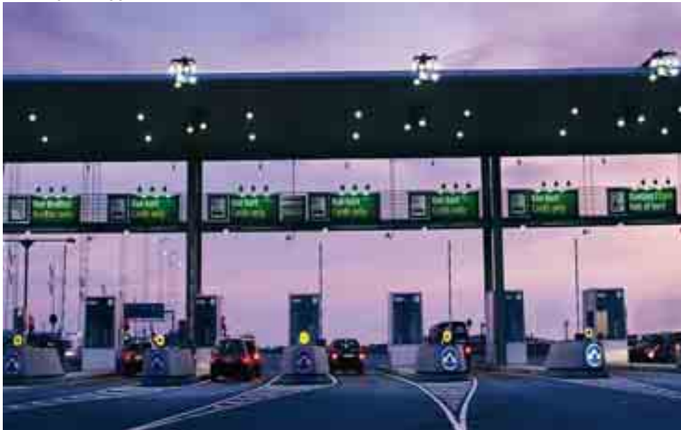
Betalingsanlægget ved Storebælt
