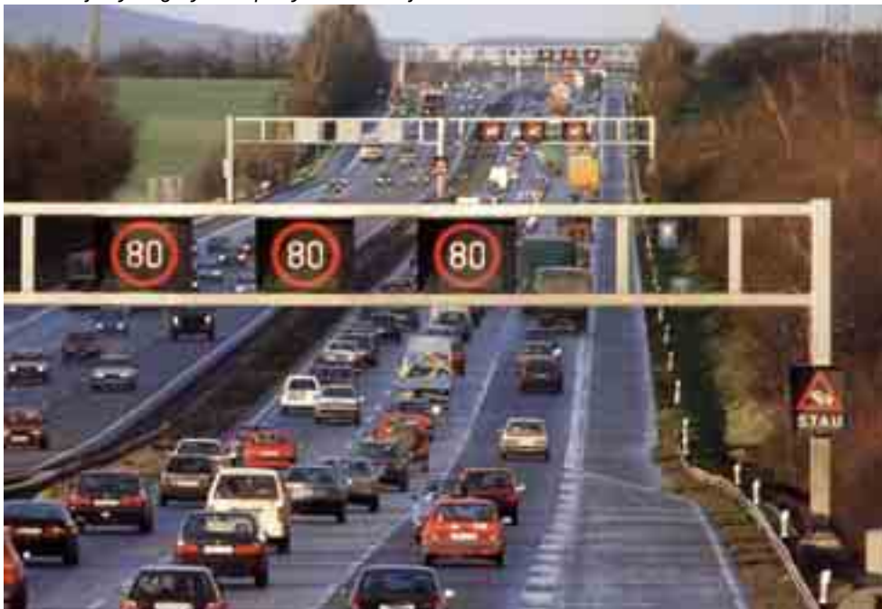
Motorvejsstyringssystem på tysk motorvej
